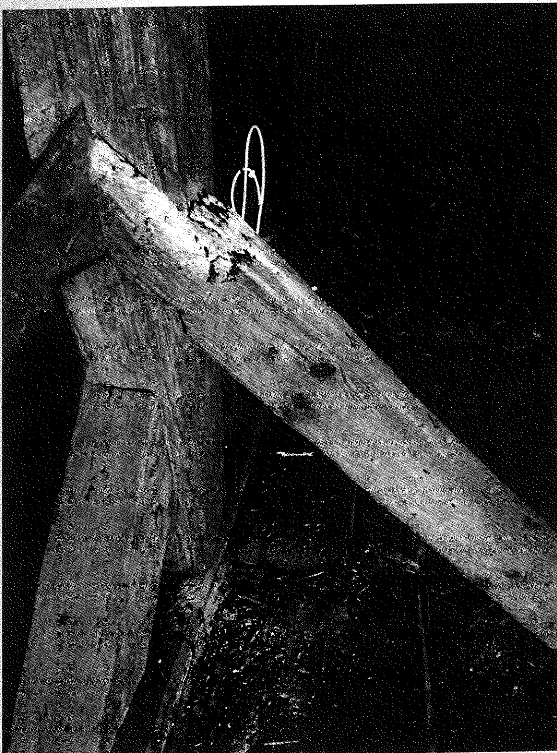
Fot. [ 23] Kołatek uparty ( Anobiumpertinax L.) - widoczne otwory z usypaną mączką drzewną co świadczy o aktywności owadów. Fot. autor.
