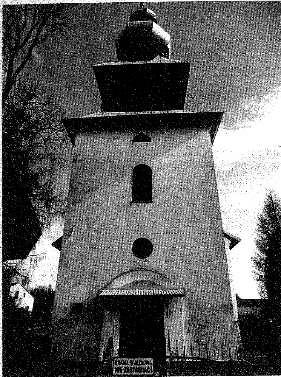
Fot.[ 3] Wygląd budynku od strony zachodniej. Fot. autor.
